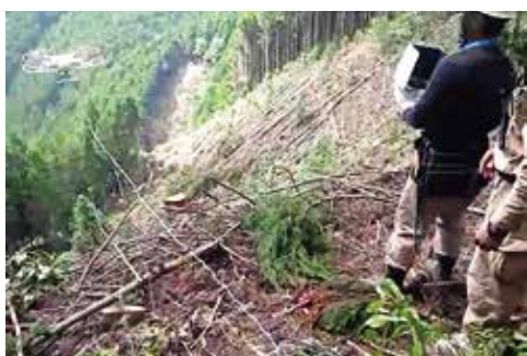
ドローンによるリードロープ引き回し
