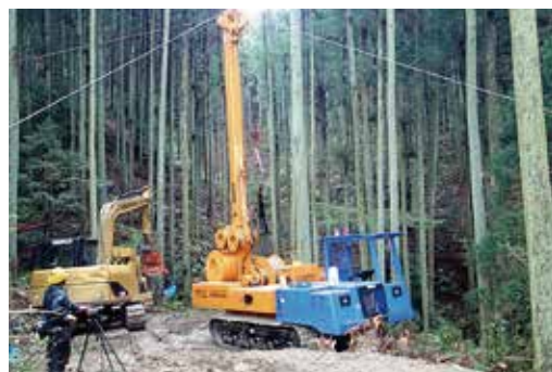
タワーヤードによる集材
