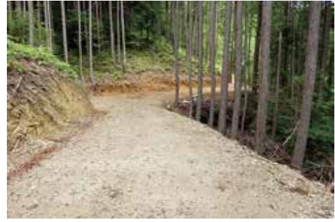
森林作業道の開設
