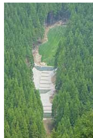
治山工事による復旧
