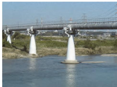
耐震補強後の水管橋
