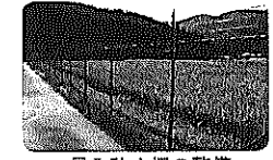
侵入防止柵の整備
