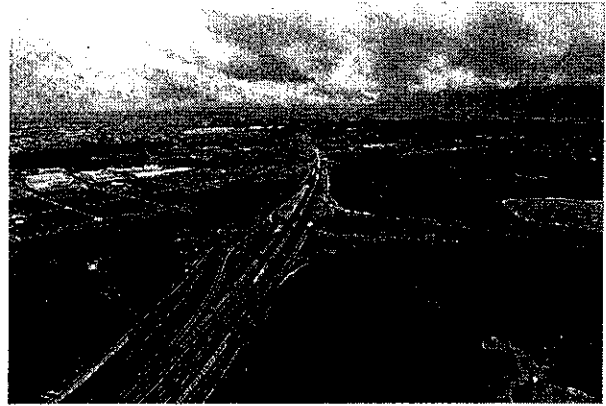
延伸した新名神高速道路と東海環状自動車道 (新四日市JCT)
