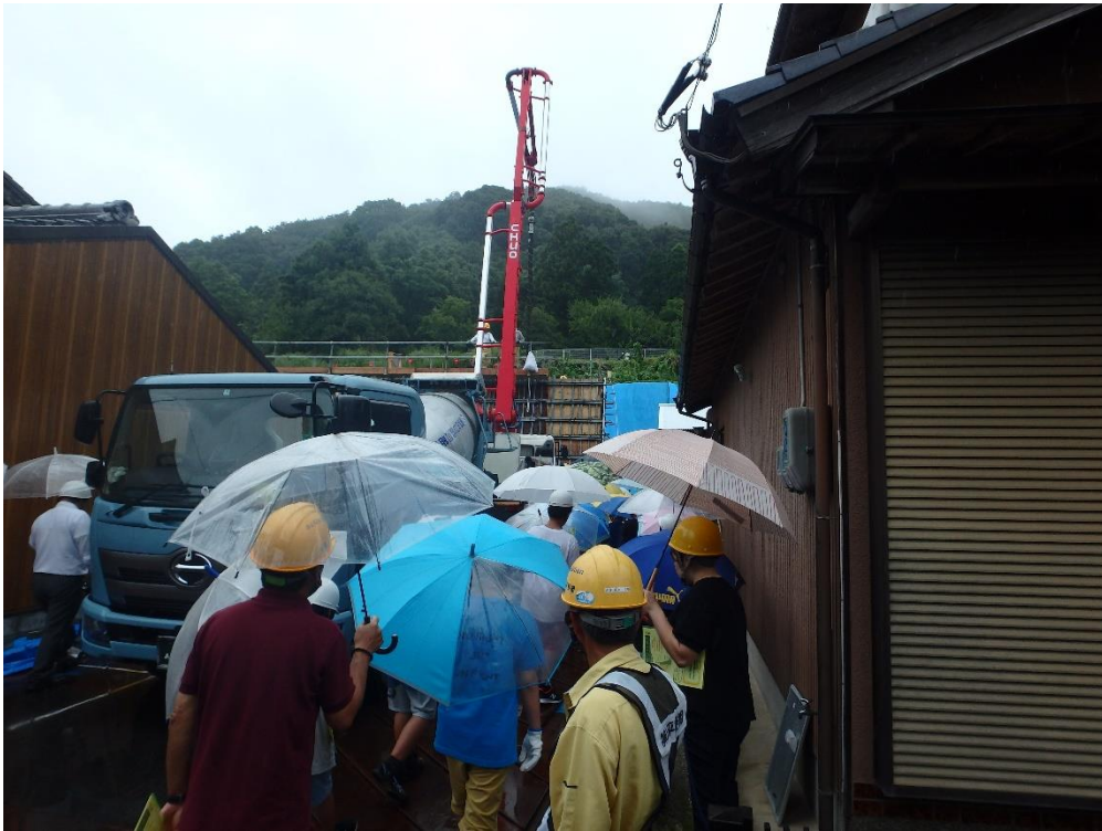
【工事中の現場を見学する西小学校の皆さん】
