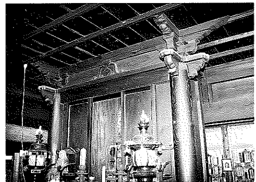
本竜寺本堂内陣（紀和町）
