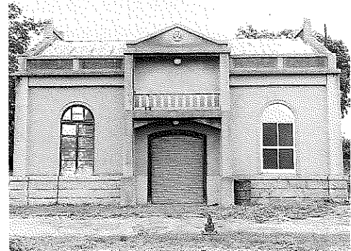
上野市上水道水源地送水機関室
