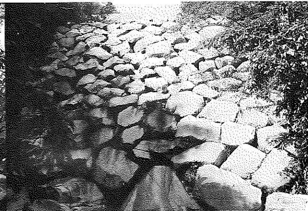
猫谷第二堰堤(菰野町)
