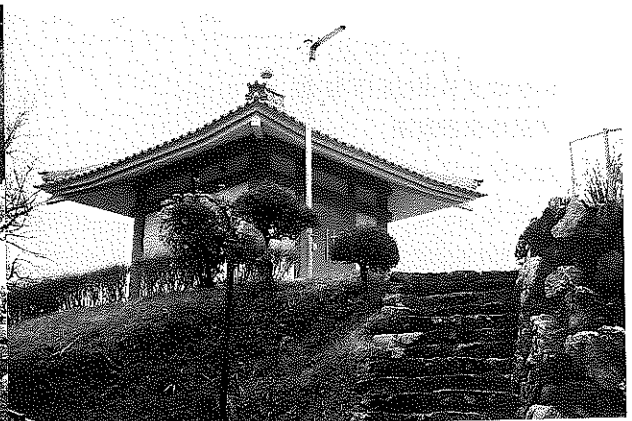
木造十一面観音立像保存施設（度会町）
