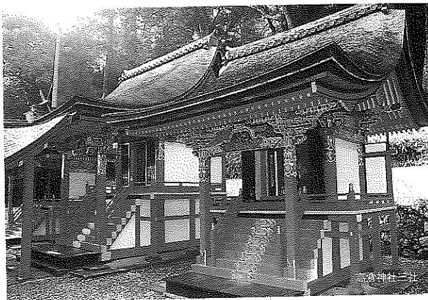
高倉神社本殿他2棟（上野市）
