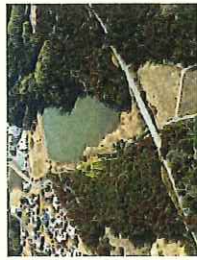
下流に家屋等のあるため池
