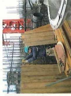
【コンクリートを流し込むための型枠を 組む作業の様子】
