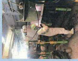
溶接作業の様子
