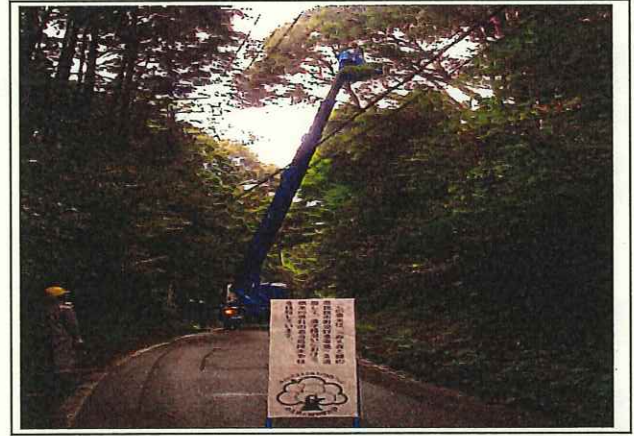
写真4 白木町(作業中)「みえ森と緑の県民税」を活用した取り組みであることを記した工事看板の設置状況
