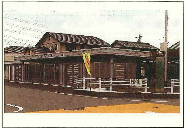
写真2 事業完了(遠景)
