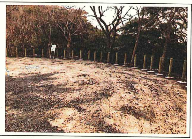
写真3 転落防止柵(実施後) 木柱とネットで囲い安全性向上
