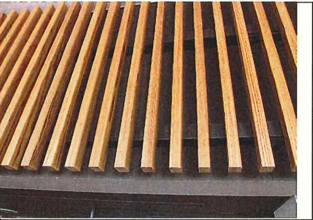
写真5 設置した木製ルーバー
