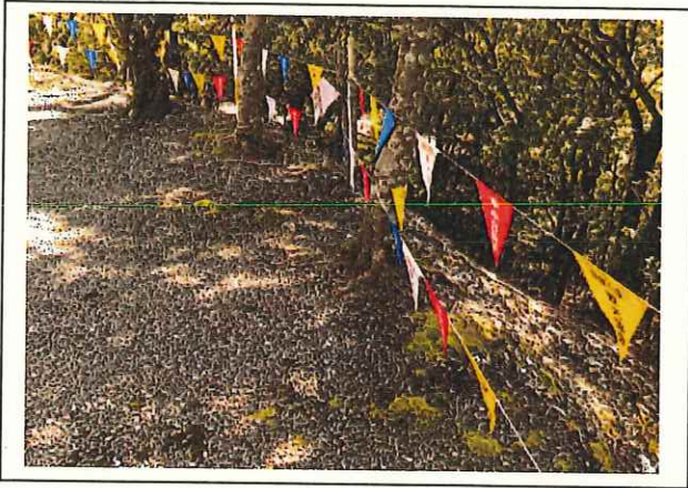
写真1 転落防止柵(実施前) 急な斜面になっており危険
