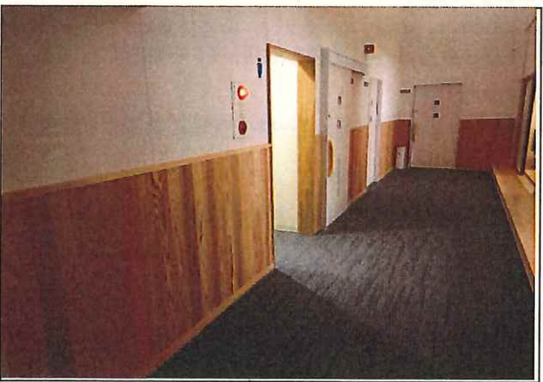
写真6 廊下 腰板状況
