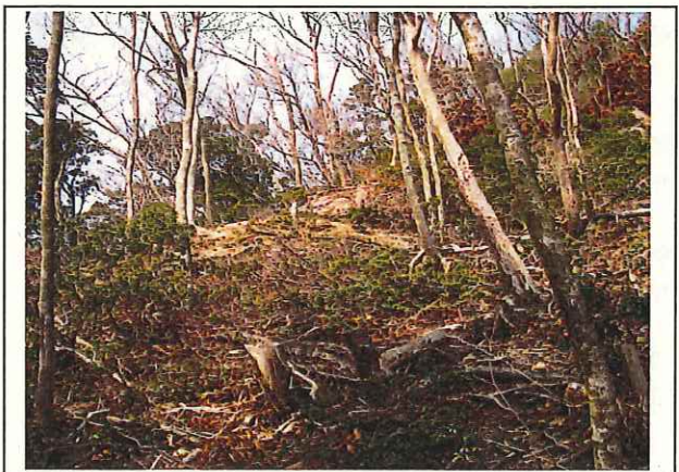
写真6 安坂山町字仙ヶ嶽(着工後)
