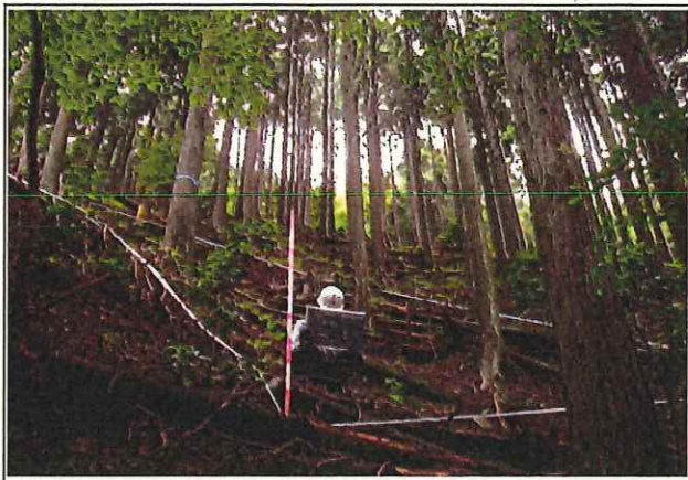
写真1 関町坂下字奥若妻(着工前)
