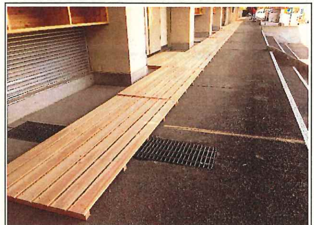
写真6 【整備後】 ざら板設置後の状況
