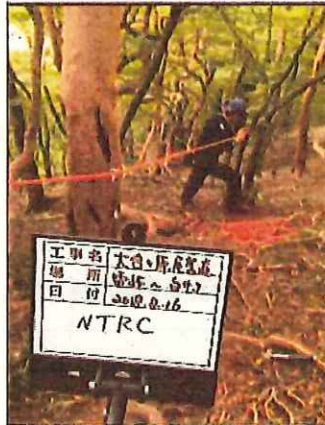
写真4 【実施中】 ガイドロープ設置
