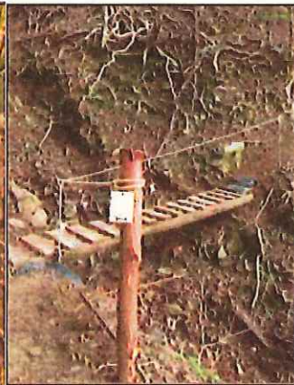
写真5 【実施中】 架橋設置
