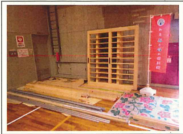
写真1 【整備中】 建具の設置の様子
