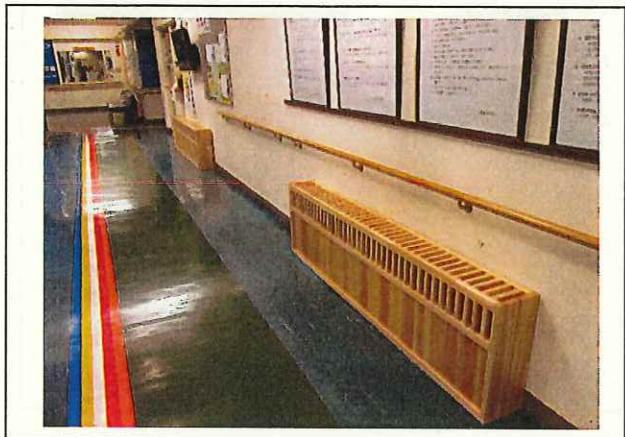
写真2 整備された木製備品 (暖房器具目隠しBOX)
