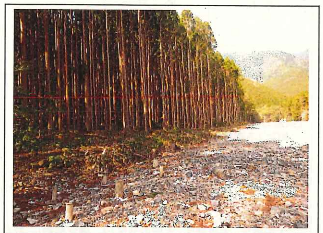
写真2 大野内地区【実施後】 立枯木の伐採・搬出
