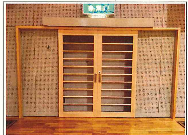
写真4 【整備後】 両引き建具設置後の状況
