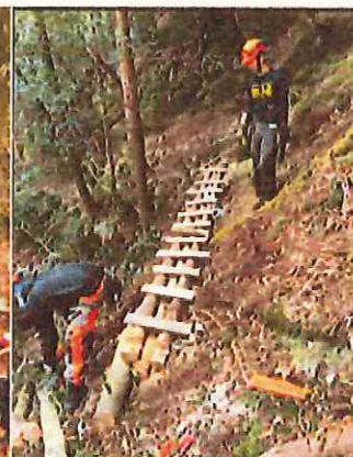
写真9 【実施中】 架橋設置
