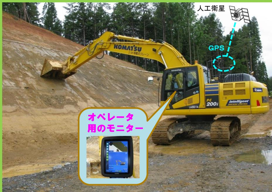
バックホウに設置したGPS、ストロークセンサ、チルトセンサから得られるバケット刃先位置を、重機に搭載したモニターに、設計形状と比較表示する。現地丁張り無しの施工が可能になる。
