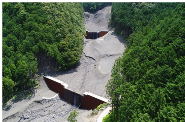
治山事業 復旧状況（紀北町）
