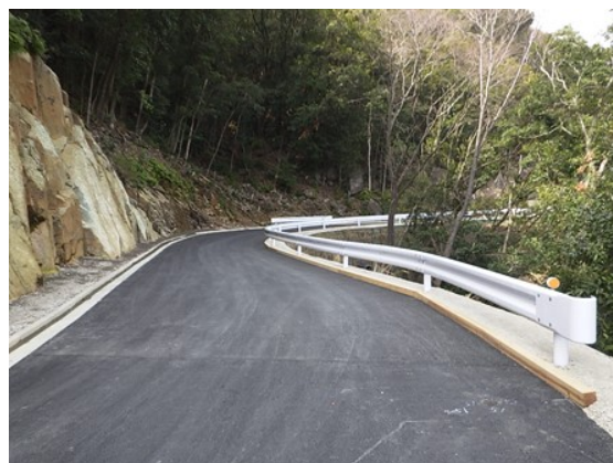
林道開設 浅谷越線（熊野市）
