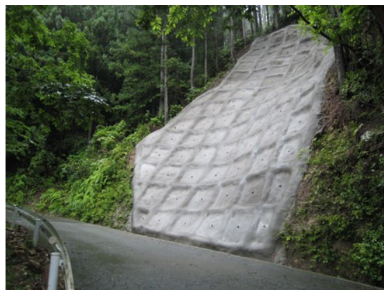
林道 有間野浦谷線 復旧状況（大台町）
