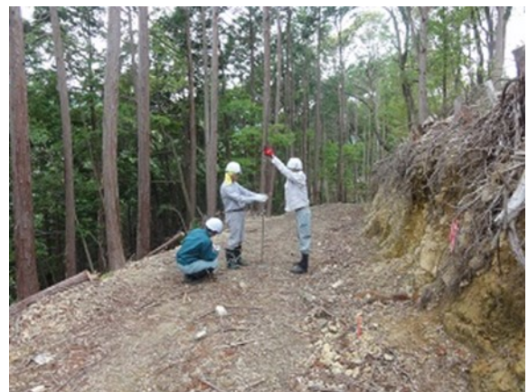
森林作業道の路体支持力の調査
