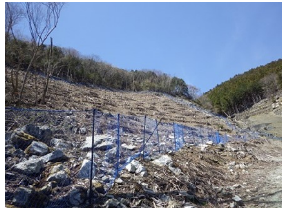
植栽地への防護柵の設置（松阪市）
