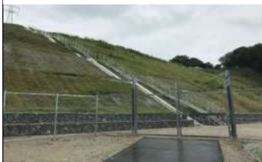
④ フェンス工、門扉(南側)
