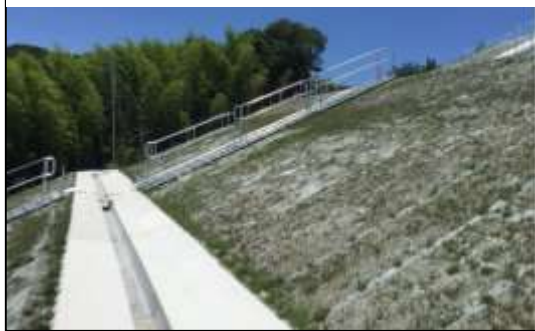
① 階段、雨水排水
