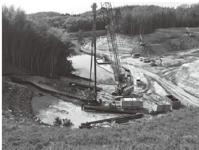
(平成31年3月に完成した中溜池側の染み出し抑止工の施工状況 平成29年4月撮影)
