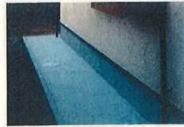
基礎周囲の犬走り
