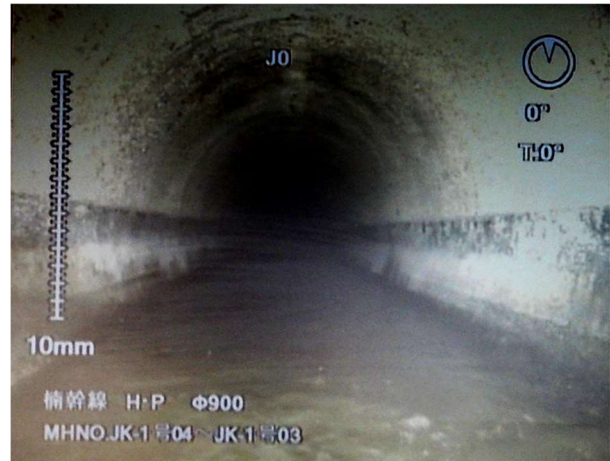
管渠内部の状況
