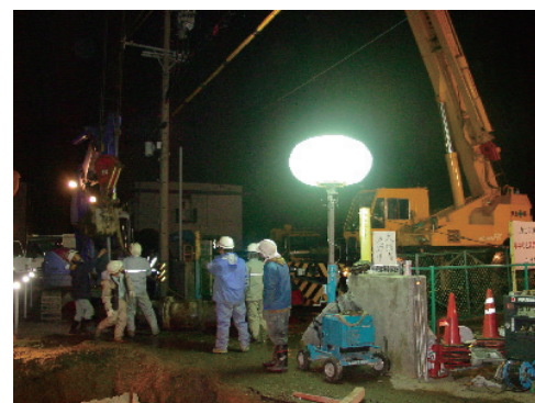
夜間の漏水復旧作業
