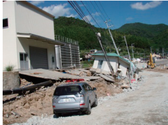
【浄水施設の被災状況(熊野市)】
