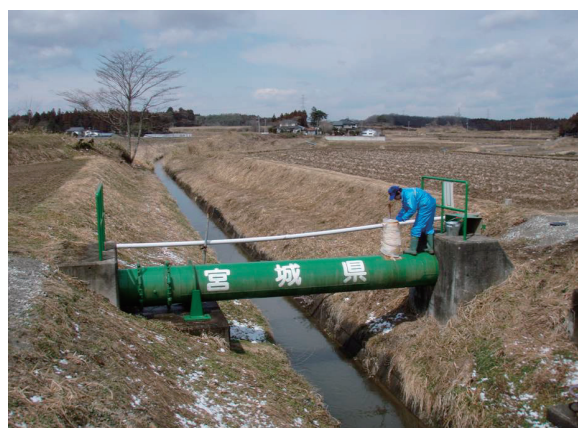
【水道施設・管路の点検(宮城県)】
