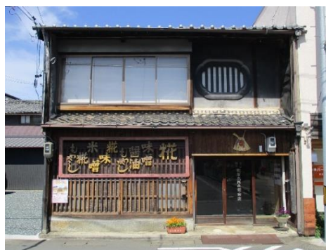
店舗兼主屋 外観(南西から)
