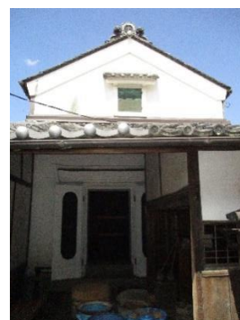
道具蔵 外観(南西から)
