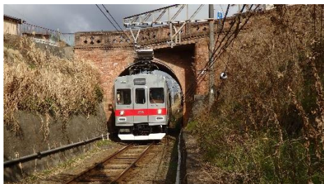
桑町跨線橋(南から)
