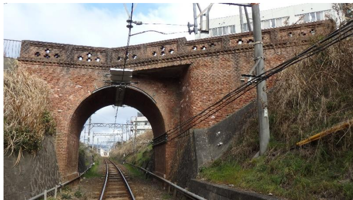
桑町跨線橋(南から)
