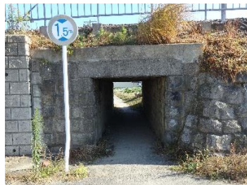
小田第二暗渠(西から)
