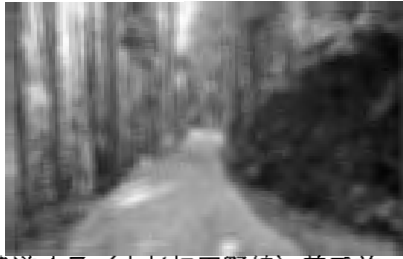
農道4号（大杉奴田野線）着手前
