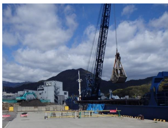
港湾受入の状況（尾鷲市）
