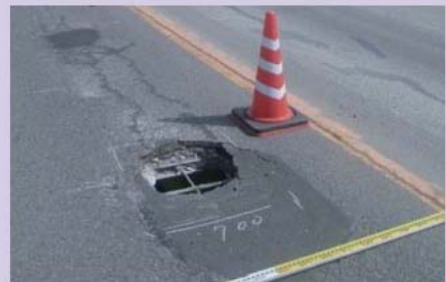
ひょうめん 表面(コンクリート)の一部が抜け落ち、 あな 空いた穴
