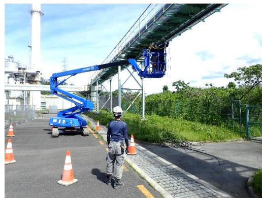
電線・ケーブル撤去状況
