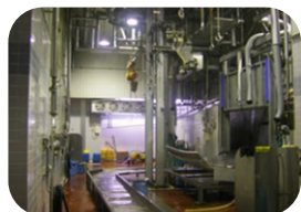
食肉センター内の加工設備
