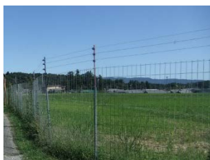
侵入防止柵の整備
