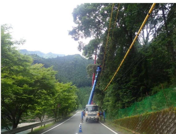
伐採作業の状況
