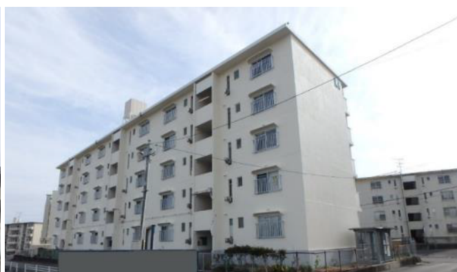
↑ 長寿命化型改善 (R6棟 外観)
