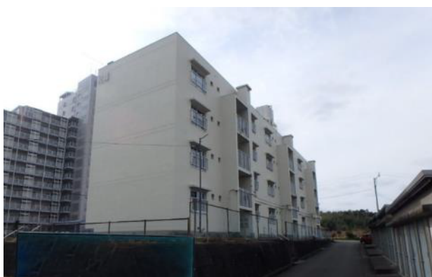
↑ 長寿命化型改善 (R4棟 外観)
