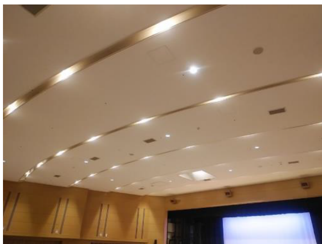
↑ 照明設備更新（講堂）
