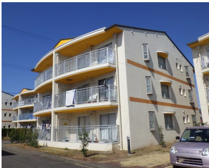
↑ 長寿命化型改善 (R4棟 外観)
