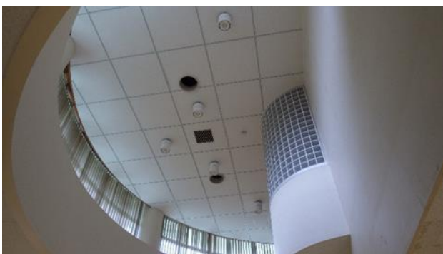
↑ 寄宿舍共用棟（軽量天井設置）
