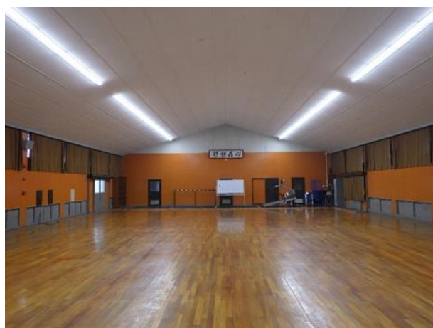
↑ 武道場（軽量天井設置）
