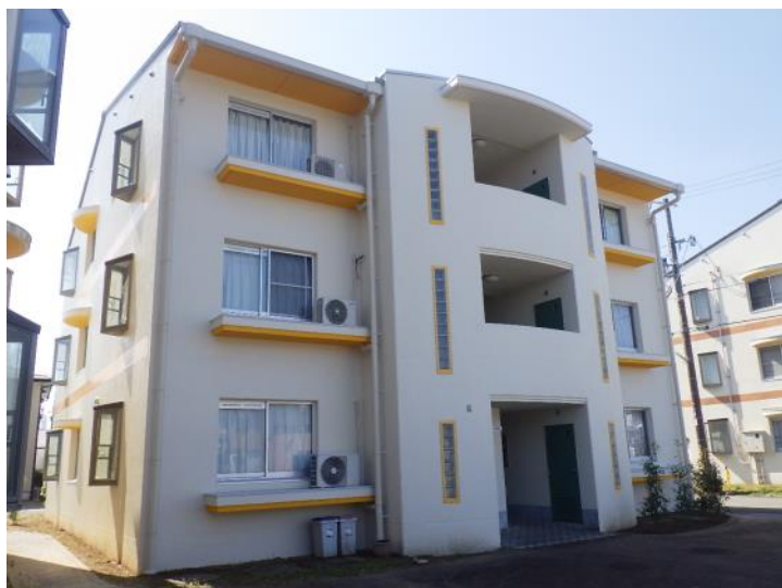
↑ 長寿命化型改善 (R4棟 外観)
