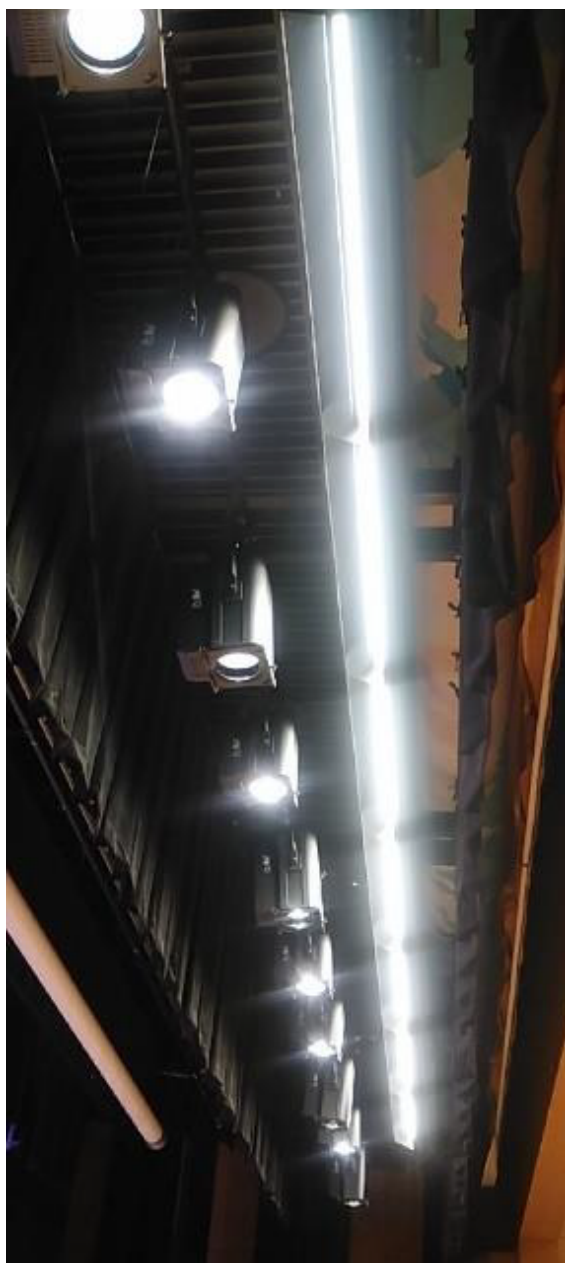
↑ 照明設備更新（舞台）
