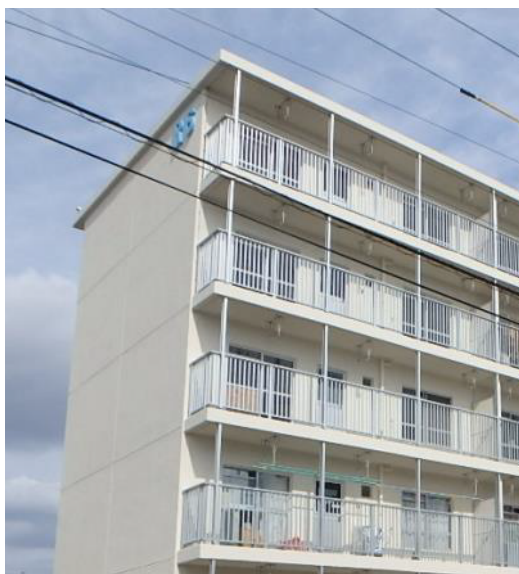
↑ 長寿命化型改善 (R6棟 外観)
