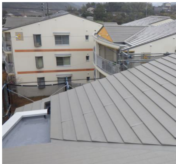
↑ 長寿命化型改善 (R4棟 屋根)
