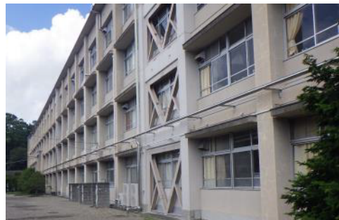
↑ 新設配管（普通教室棟）
