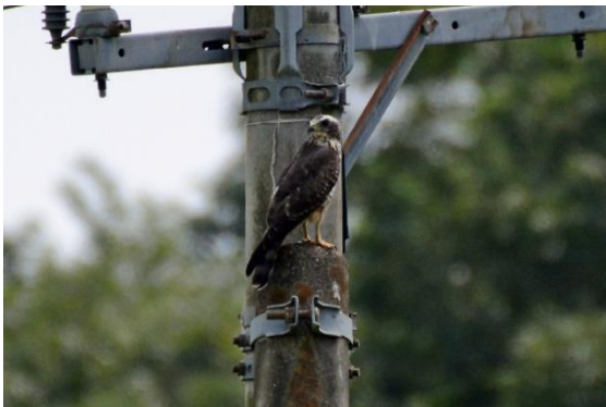
写真 2-5-13 電柱にとまる幼鳥
