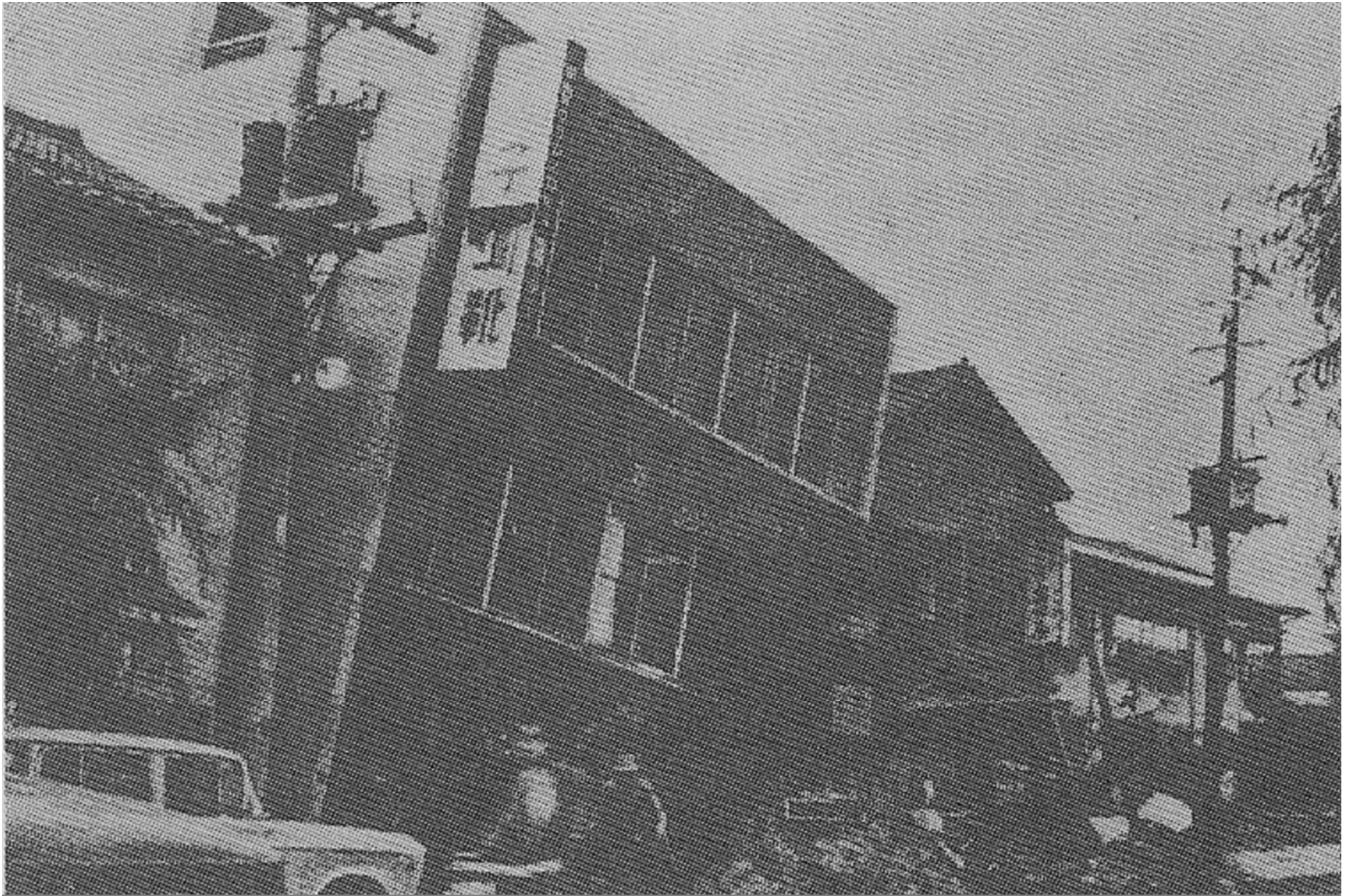
全体沈下が1 mを超える被害例 (P. 73)
