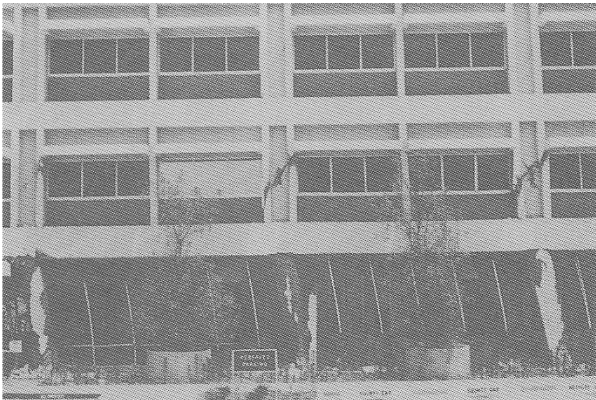
柱の損傷に伴う大きな水平変形の被害例（P. 75）
