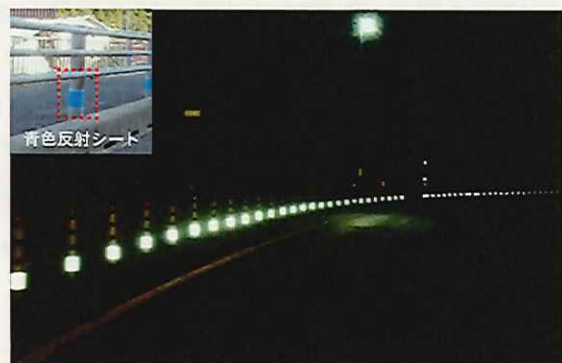
施工・管理が容易で景観に配慮した 視線誘導標(青色反射シート) (国道29号(兵庫県宍粟市))
