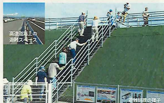
津波警報発令時の高速道路への避難 (高知東部自動車道(高知県香南市))
