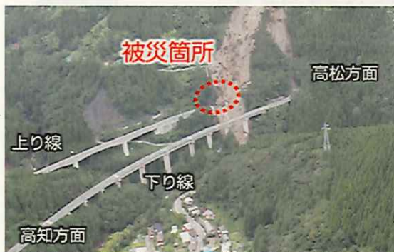
上下線の被災を免れた高速道路の分離構造 (高知自動車道(高知県大豊町))
