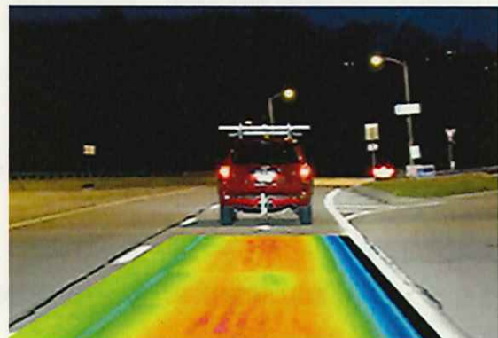
NEXCO 西日本の高解像度カメラ(HDV)と 赤外線カメラを用いた
