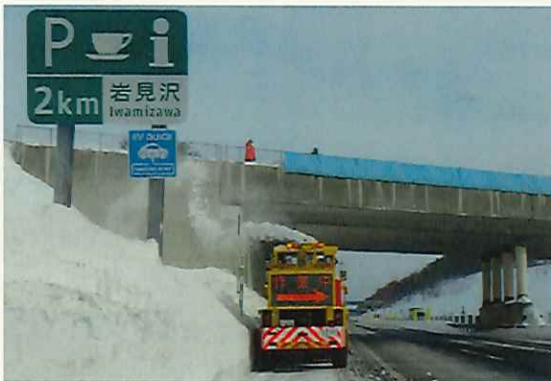
準天頂衛星を活用した除雪車運転支援システム※ (道央自動車道(岩見沢～美唄間))
