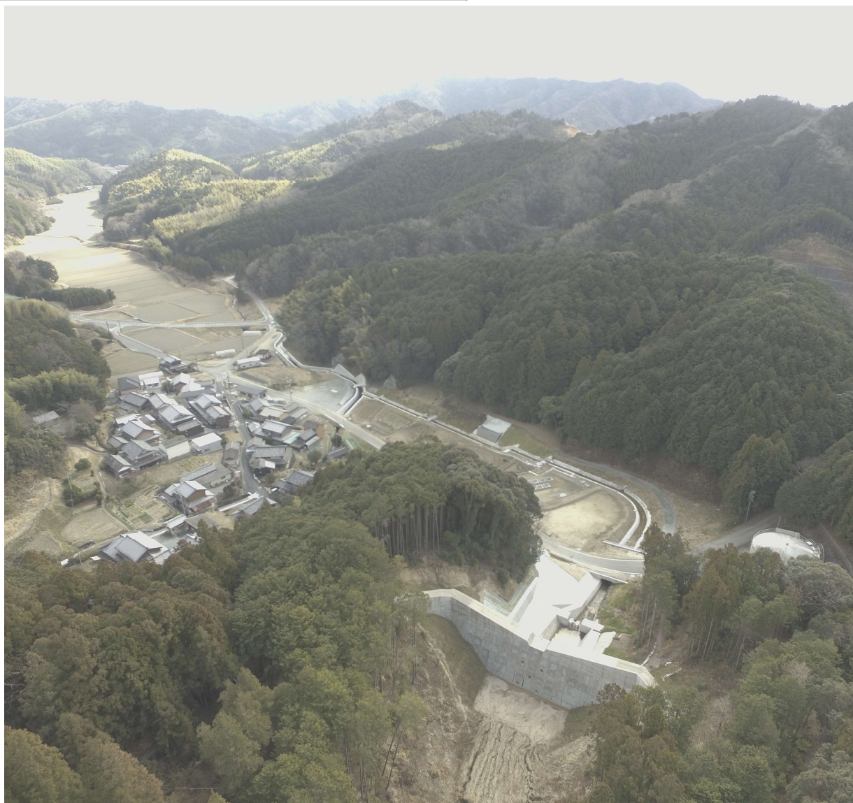
本川（砂防えん堤及び溪流保全工）完成
