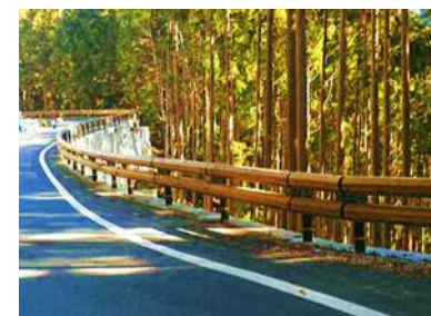
附属施設の例(木製ガードレール) 写真提供:和歌山県
