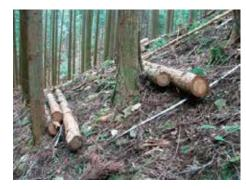
写真 伐倒木を利用した土砂止め
