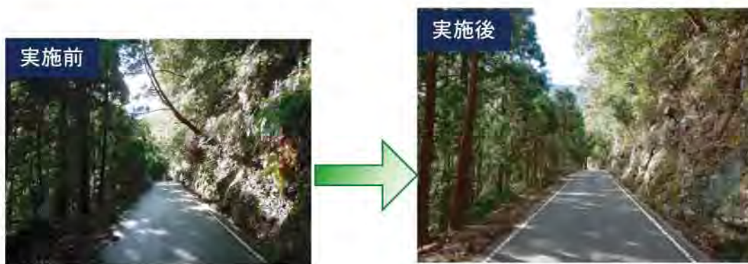
写真 【暮らしを守る危険木伐採事業】（熊野市） 集落間を結ぶ生活道路沿いにおける倒木等の恐れがある危険木等の伐採除去 危険木除去延長：3,300m
