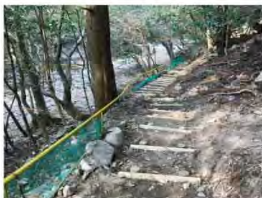
写真 【小岐須溪谷整備事業】（鈴鹿市） 安全に小岐須溪谷の自然に親しみ楽しめる環境づくりのため、登山道を整備しました。 事業量：落石防止柵L=78.0m、丸太階段117段
