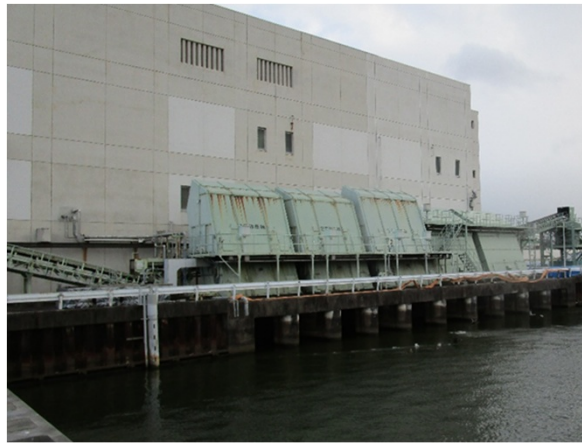
ポンプ場整備
