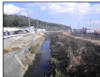
朝明新川における河川整備 (四日市市)
