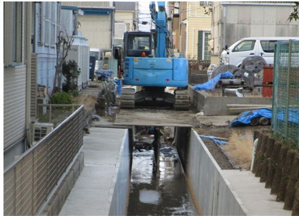
下水道（雨水排水）施設の整備
