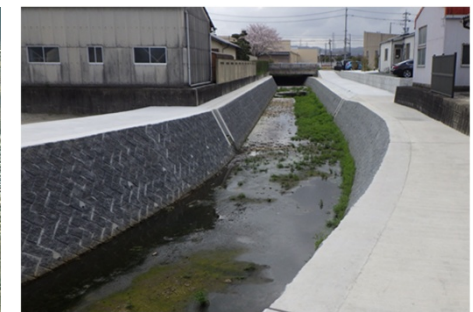
九手川における護岸整備 (松阪市)
