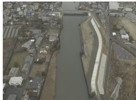
三渡川における河川整備 (三重県)
