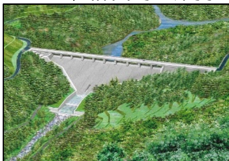
鳥羽河内ダム建設事業 (三重県)
