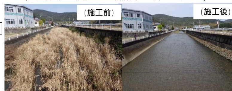
磯部川緊急浚渫推進事業 (三重県)
