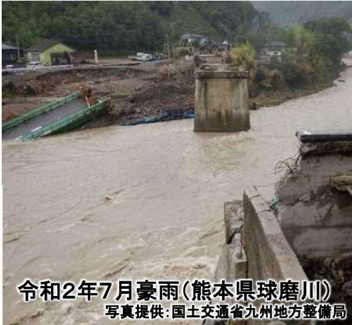
渡河部の橋梁は、橋脚数が多い構造の場合、水圧や流木の衝撃等で橋自体が流失するリスク、橋の基礎部分が激流で洗堀されるリスク等があります。
