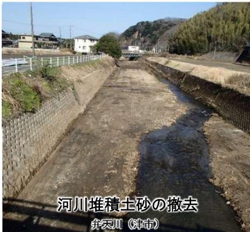
県の河川事業により、毎年の堆積量を上回る約22万 $m^3$ を撤去します。加えて、民間の砂利採取について、制度を拡充することにより、毎年15万 $m^3$ 程度の撤去を目指します。これらにより、**毎年合計約37万 $m^3$ を撤去**し、蓄積した土砂も含めて計画的な撤去を進めます。
