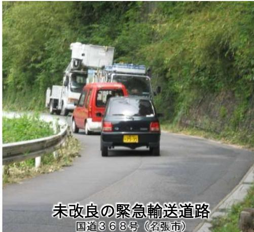
現在の道路構造令は、車道の幅員を5.5m以上としています。これを満たさない未改良の道路では、車両のすれ違いが困難であるなど、災害時の緊急輸送を円滑に実施することが出来ないリスクがあります。このようなリスクがある道路が、第二次緊急輸送道路で約19km確認されています。
