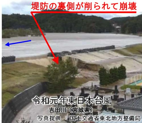
想定を超える大雨で河川の水が堤防を越えると、堤防の裏側が削られて**決壊するリスク**があります。背後に人家等がある箇所、過去に氾濫の発生や堤防高等が不足している河川堤防が約38km確認されています。
