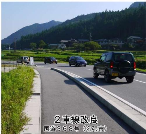
現道の拡幅整備(5.5m以上)や、線形の悪い箇所ではバイパスを整備するなど、大型車両が容易にすれ違いの2車線の道路に改良を行います。
