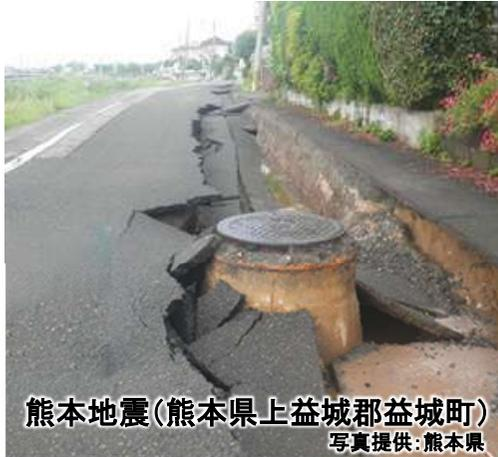
阪神淡路大震災以前の基準で設計された下水道管路は、供用中に発生する確率の高い地震(L1地震動)をもとに設計されており、南海トラフ地震等の大規模地震が発生した場合損傷し、下水が流下出来ない事態や道路陥没等が生じるリスクがあります。この様なリスクの可能性のある開削あるいは推進工事で施工された管路の区間が、約2kmあります。
