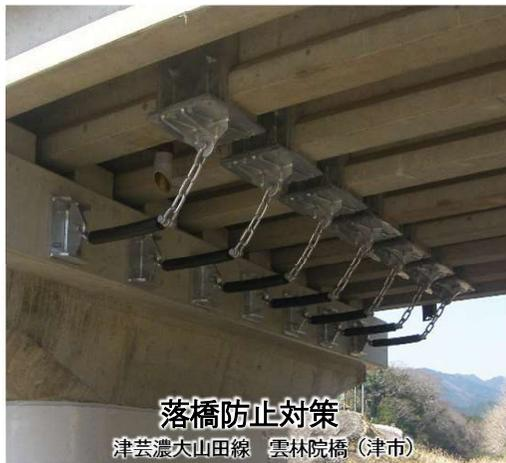
阪神淡路大震災クラス等の大規模地震が発生した際にも損傷が限定的なものに留まり、速やかに機能回復が出来るように対策を講じます。
