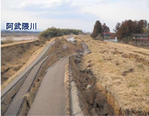
河川堤防は日本海中部地震以前は地震による外力を考慮しておらず、大規模地震が発生した場合、沈下や損傷といった変形が生じ、土地の低いゼロメートル地帯では、河川の流水が越流した際に浸水被害が長期化するリスクがあります。このようなリスクの可能性があるゼロメートル地帯における河川堤防の区間が約6km確認されています。
