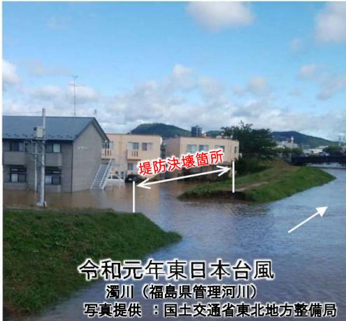
水害による被害軽減を図るため、洪水予報河川、水位周知河川は、洪水浸水想定区域図を作成・公表しています。しかし、令和元年東日本台風では、それ以外の中小河川でも多数の堤防が決壊、人的被害が発生しており、このような中小河川が508河川あります。
