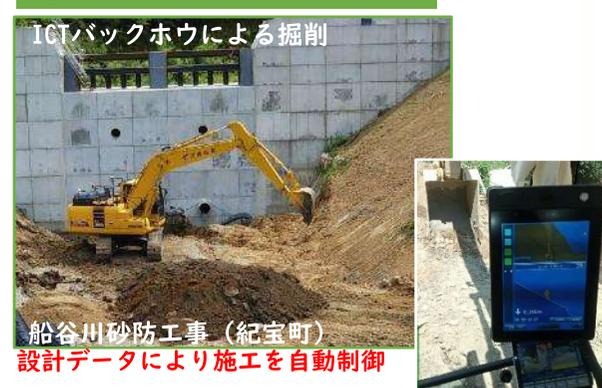
設計データにより施工を自動制御
