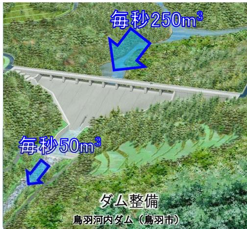
鳥羽河内ダムを整備することにより、河川のピーク時の流量を1/5に抑え、浸水被害を軽減します。
