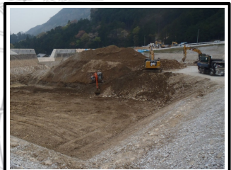
砂防堆積土砂撤去（三重県）
