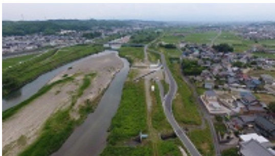
員弁川河川改修事業 (三重県)
