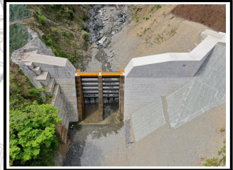
砂防堰堤整備（三重県）
