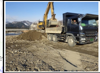
河川堆積土砂撤去（三重県）
