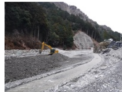
砂防堆積土砂撤去事業 (三重県)
