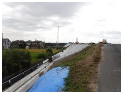
員弁川堤防強化事業 (三重県)
