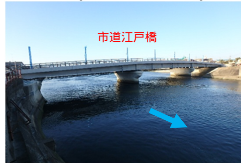
志登茂川における橋梁改築 (三重県)
