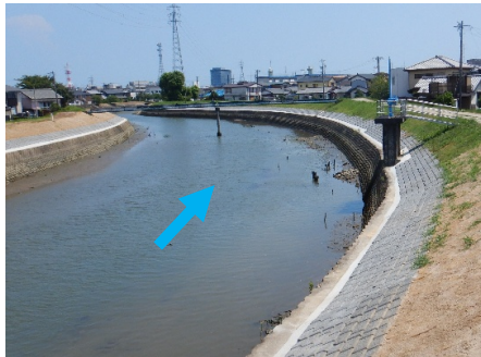
岩田川における築堤護岸 (三重県)
