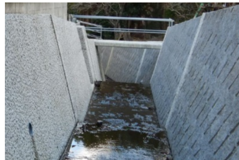
津市内河川における河道拡幅 (津市)
