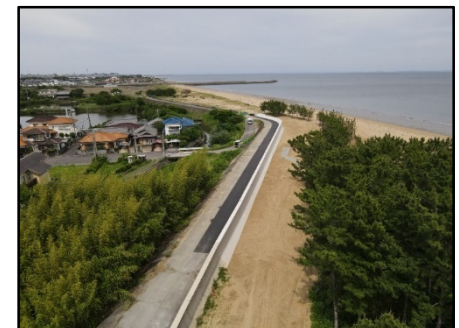
千里～白塚地区海岸における堤防整備 (三重県)
