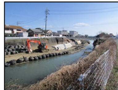
外城田川河道掘削 （玉城町）
