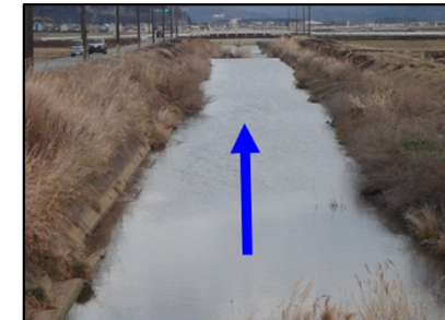
外城田川河道掘削 （多気町）
