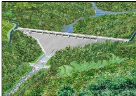
鳥羽河内ダム建設事業 (三重県)
