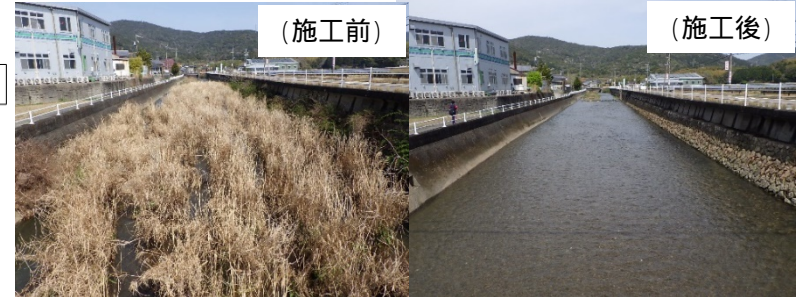
磯部川緊急浚渫推進事業 (三重県)
