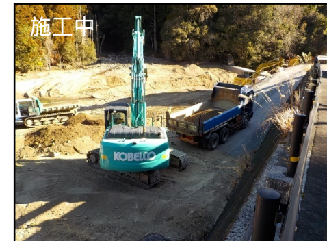
堆積土砂撤去 (井戸川) 【三重県】
