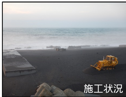
河口開削(志原川) 【御浜町】
