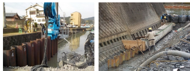
護岸整備工事施工状況
