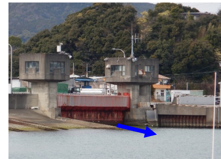
神内川防潮水門の現況
