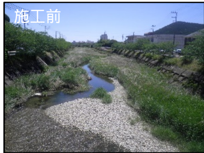
河道掘削(堆積土砂撤去)(井戸川) 【三重県】
