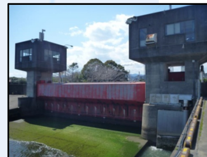
神内川防潮水門
