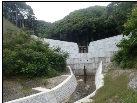
砂防堰堤の整備 (ヨドロ崎) 【三重県】
