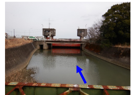
神内川防潮水門の現況
