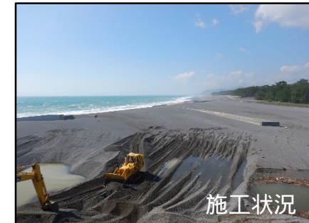
河口開削(志原川) 【御浜町】
