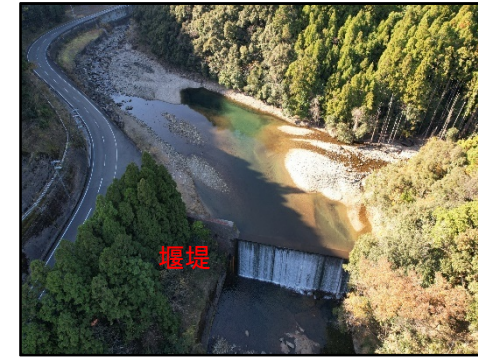
砂防堰堤堆積土砂撤去
