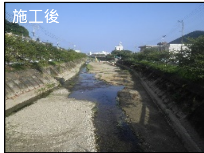
河道掘削(堆積土砂撤去)(井戸川) 【三重県】
