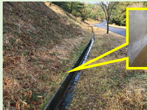
工事後の環境：三面コンクリート水路
