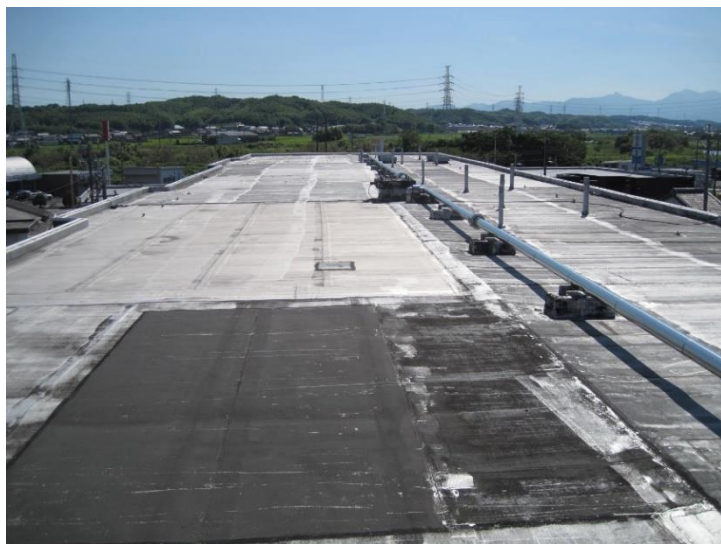
屋上防水 改修 前
