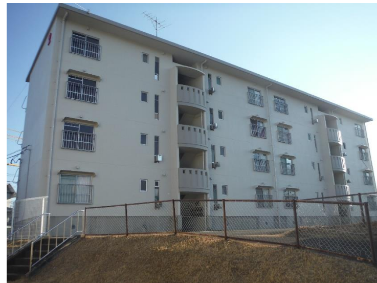
外壁塗装 改修 後
