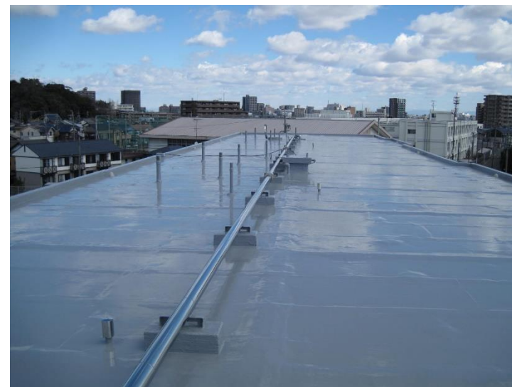
屋上防水 改修 後
