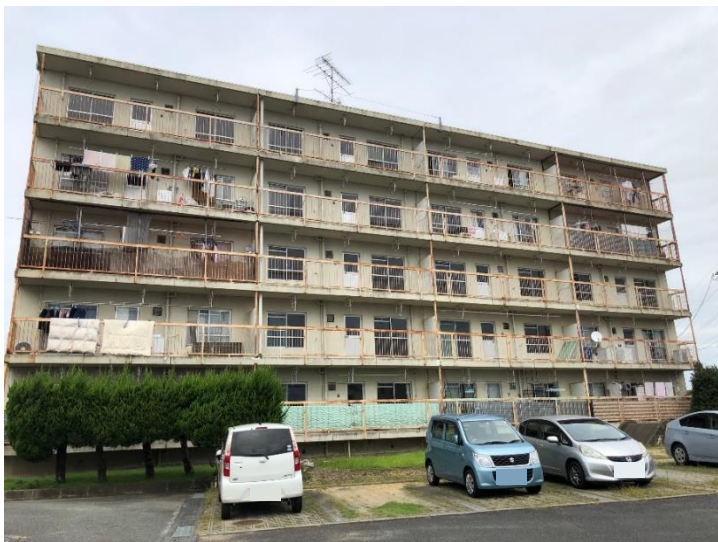
外壁塗装 改修 前
