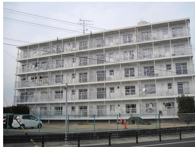
外壁塗装 改修 後
