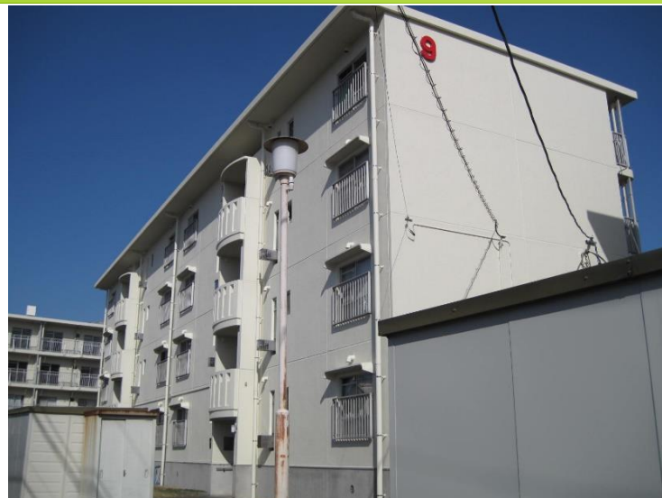
外壁塗装 改修 後
