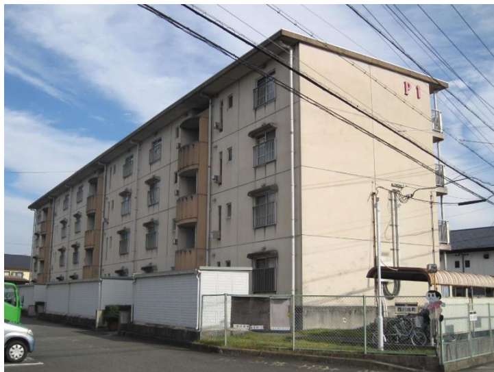
外壁塗装 改修 前
