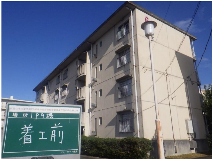
外壁塗装 改修 前
