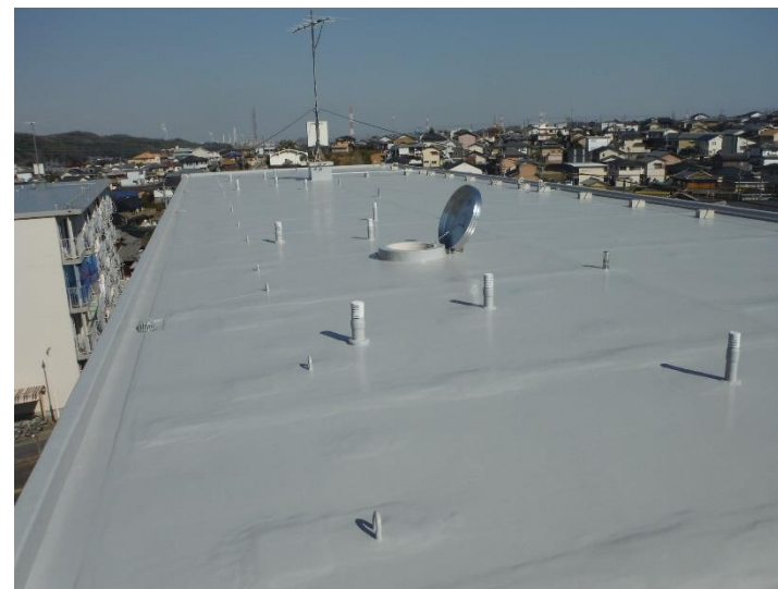
屋上防水 改修 後
