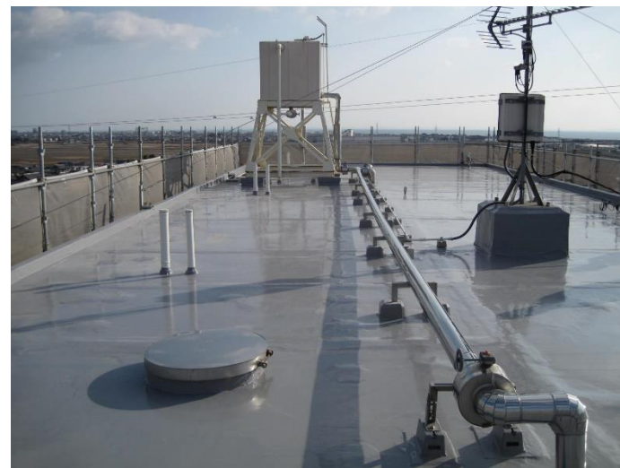
屋上防水 改修 後
