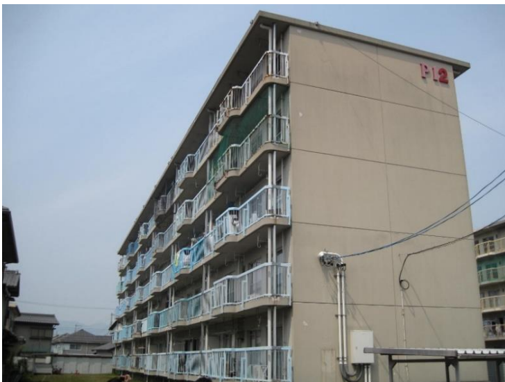
外壁塗装 改修 前
