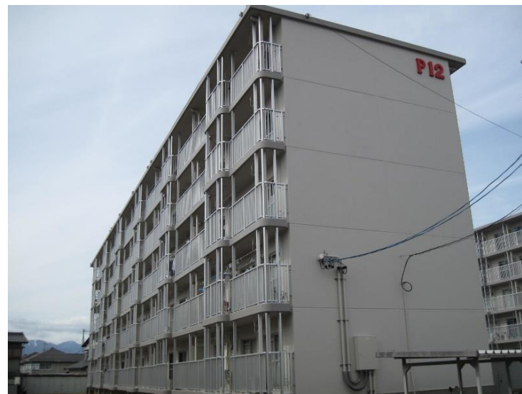
外壁塗装 改修 後
