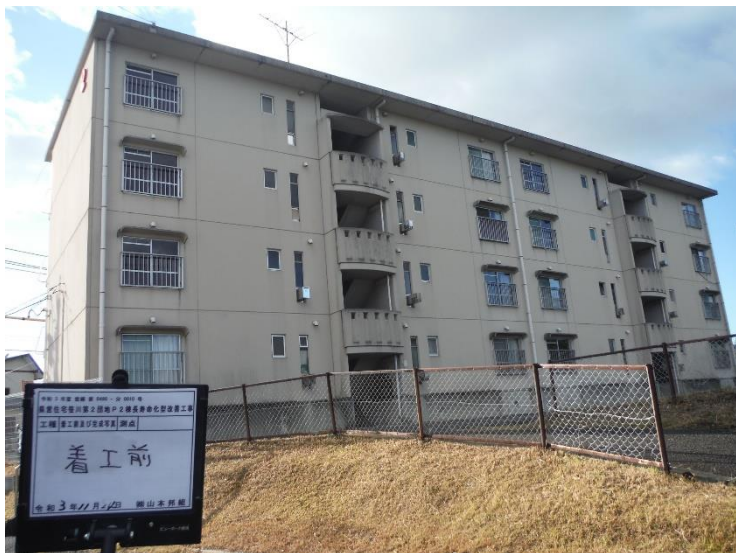
外壁塗装 改修 前
