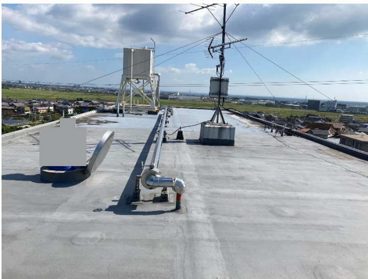
屋上防水 改修 前
