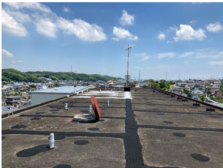
屋上防水 改修 前
