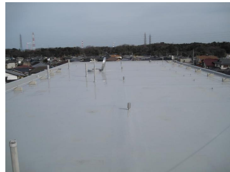
屋上防水 改修 後
