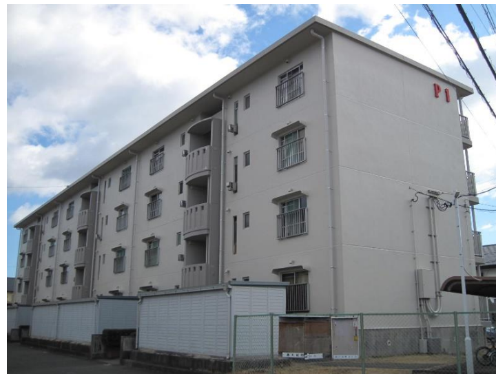
外壁塗装 改修 後
