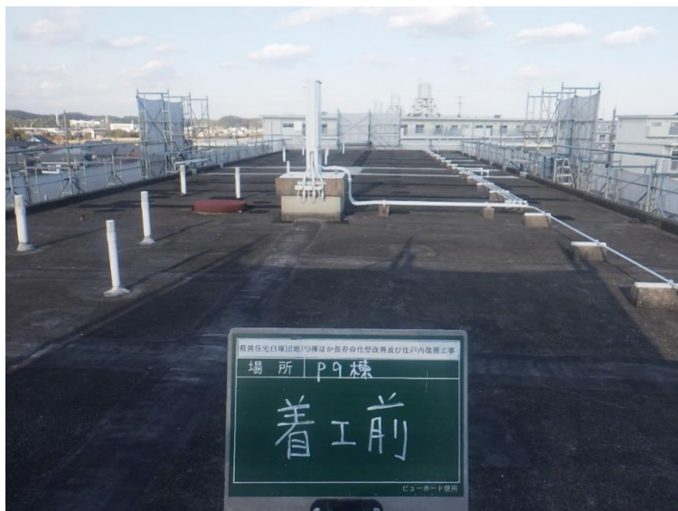
屋上防水 改修 前
