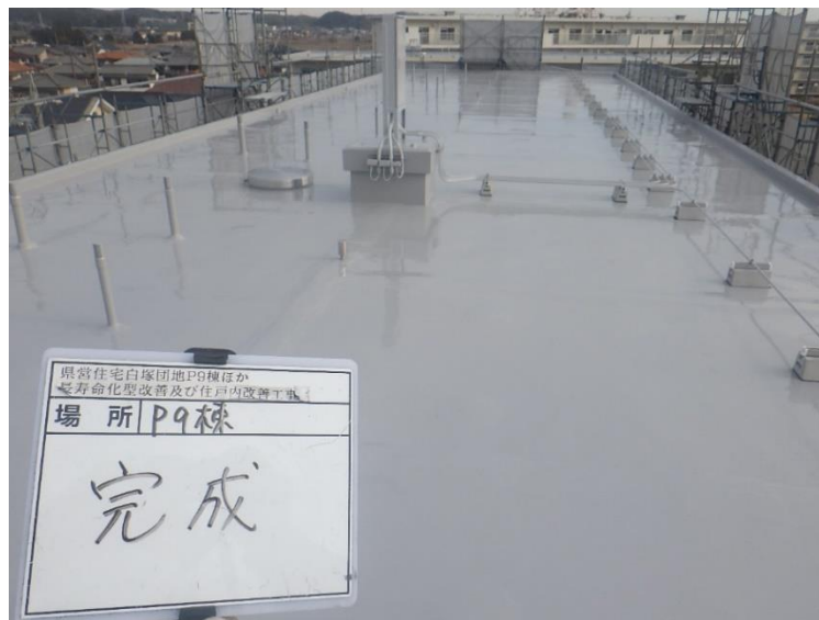
屋上防水 改修 後
