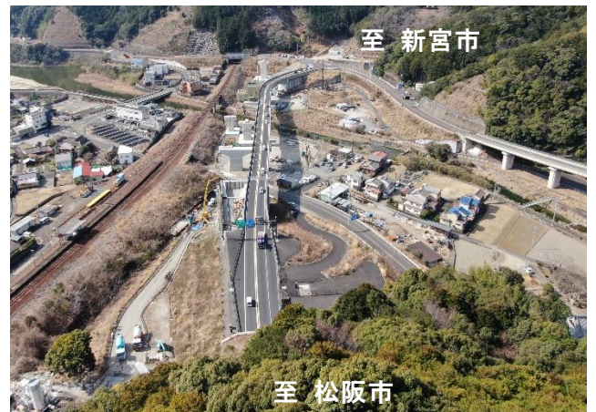
⑤熊野道路（熊野市大泊地内）
