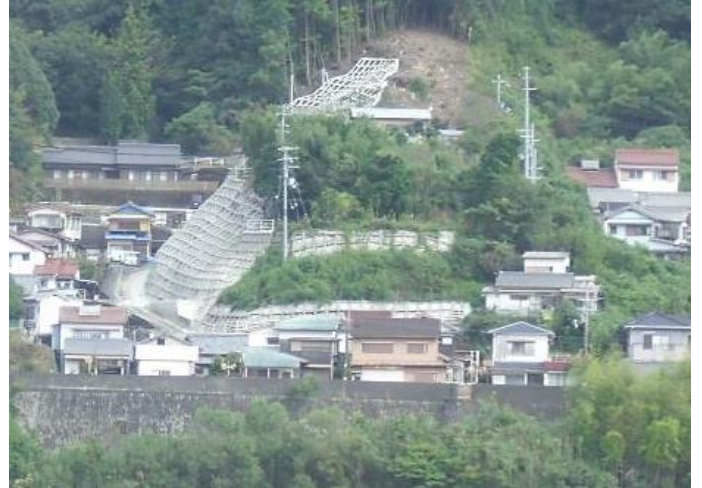
● 急傾斜地崩壊対策事業（上地3地区：紀宝町）
