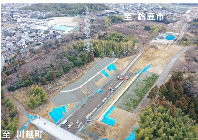
⑨北勢バイパス（四日市市曾井町地内）
