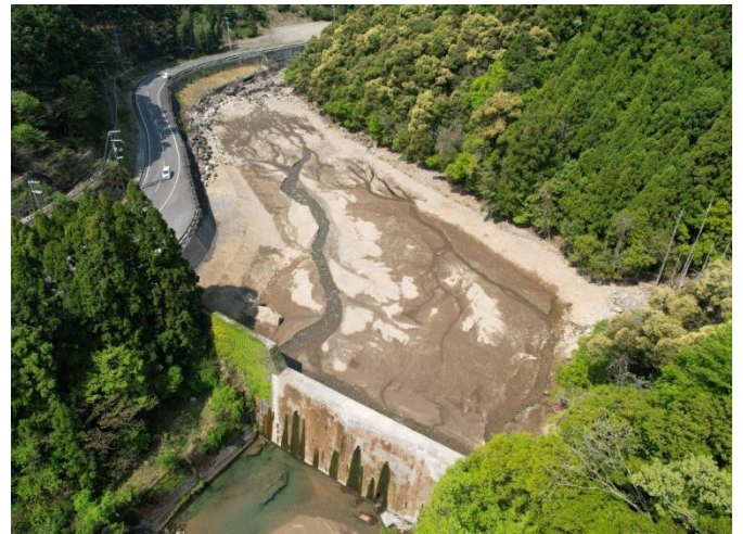
● 緊急浚渫推進事業（井戸川砂防えん堤：熊野市）
