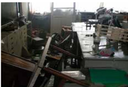
玻璃破碎的员工办公室
