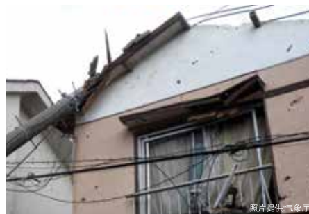
被倒塌的电线杆砸坏的房子
