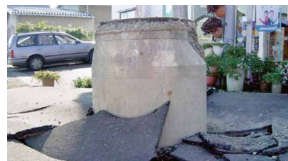
穿出地面的下水管道
