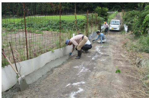
獣害侵入防護柵の補強作業
