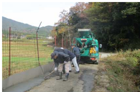
獣害侵入防護柵の補強作業
