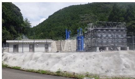
浄水施設全景
