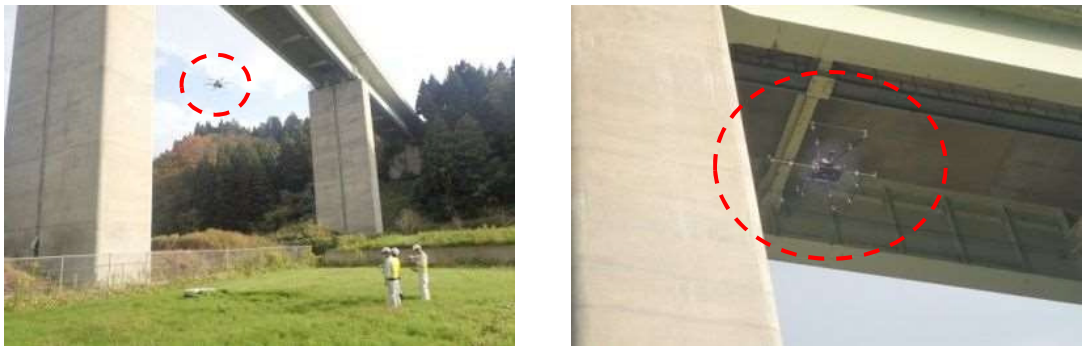
図II-9 ドローンによる点検状況
